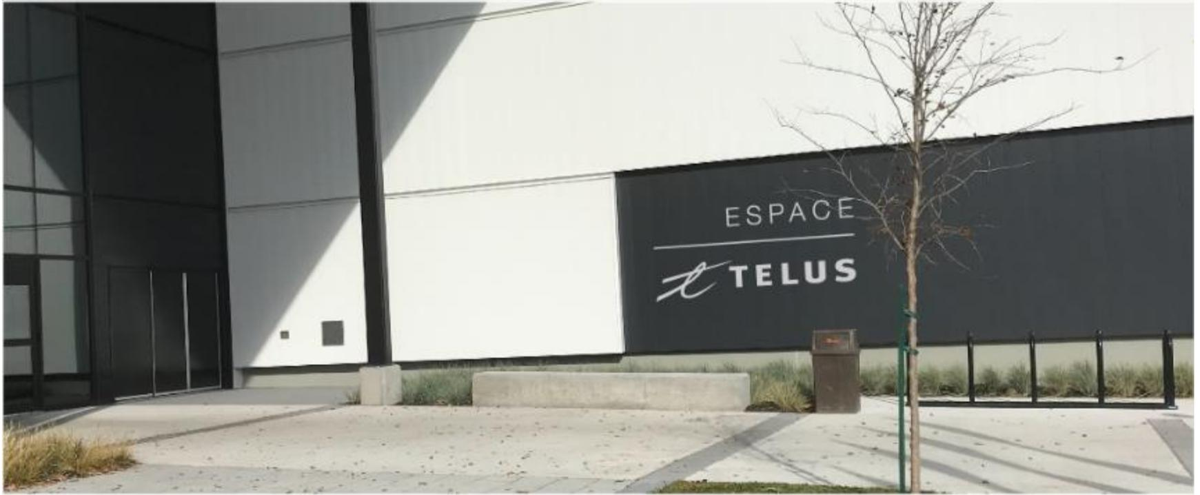
Matériaux : Intécel 1 pouce d'épaisseur avec finition en Alupanel, aluminium brossé 1/8 pouce d'épaisseur installé sur le parement existant
