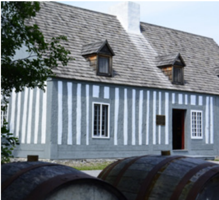
Maison Lamontagne, 2019 Source : Société rimouskoise du patrimoine
