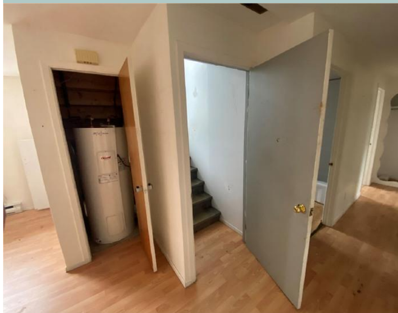
Entrée du sous-sol
